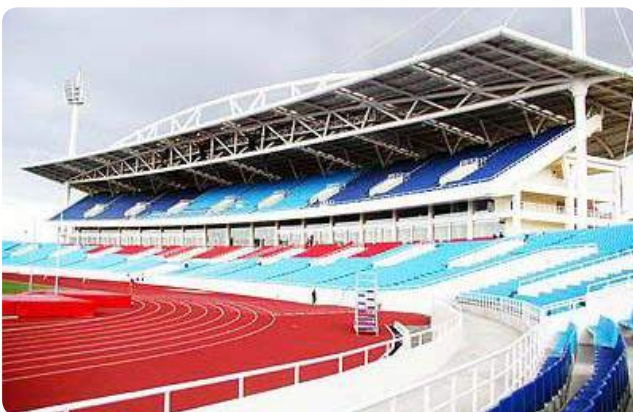
Hệ thống cáp ngầm tại sân vận động Underground cable system in stadiums
